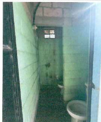
Foto 2: Reparacion del area de baños, mejorar la ubicación de los sanitario. Intalacion de puertas, pintura de las paredes.
