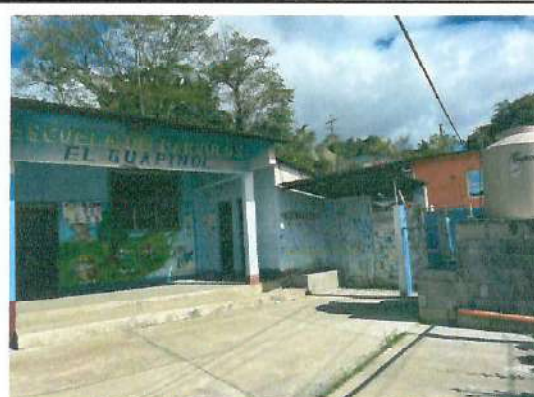
Foto 4: techado de patio tipo protico y cubierta de lamina calibre 26 troquelada con caída de agua pluviales.
