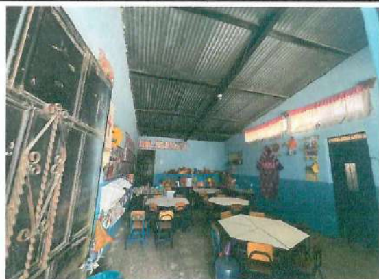
Foto 3: Instalacion del sistema electrico en aula.
