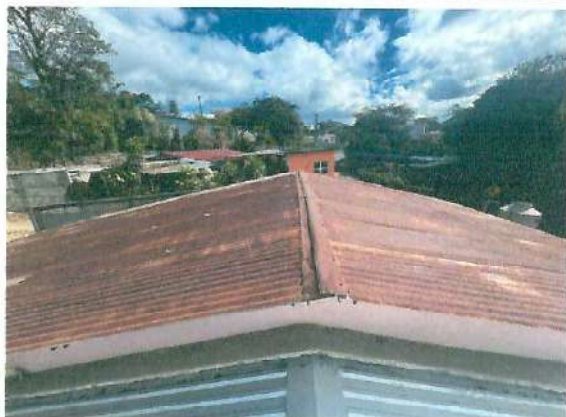
Foto 1: Cambio de cubierta de lamina calibre 26 troquelada.
